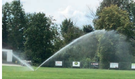
Lebensrettung für unseren Rasen: die neue Beregnungsanlage
