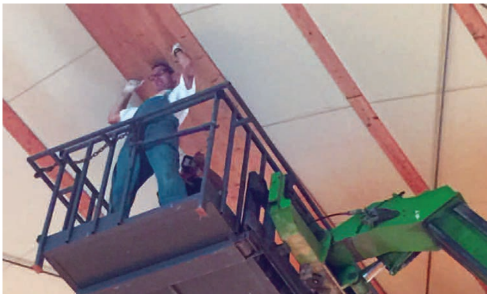
Auch die Innenisolierung der Tennishalle ist jetzt abgeschlossen
